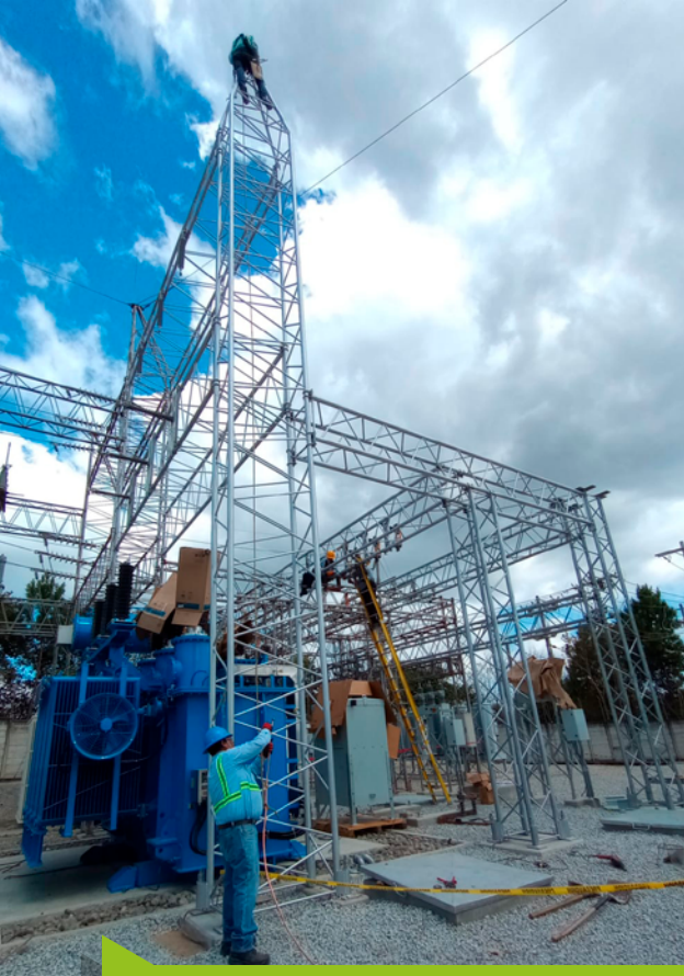
4. Montaje electromecánico Subestación Ciudad Quetzal · 90%
