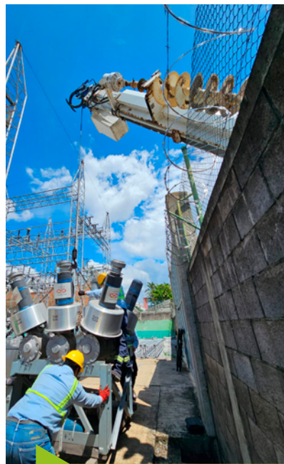
7. Ampliación · Subestación Arrazola · 35%
