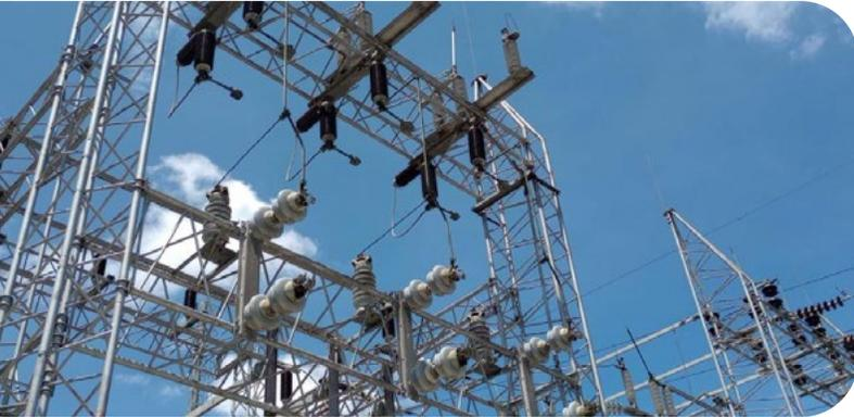
Se obtuvo un 90% de avance del proyecto de ampliación de Subestación Arrazola el cual consiste en el armado y pruebas de dos módulos pass, campos de 69 kV con montaje de un interruptor de potencia, tres transformadores de potencia, seis pararrayos, doble barra rígida, un juego de seccionadores, cableado y conexionado de equipos, en la parte de control: instalación, alimentación de cableado y conexionado de cuatro tableros PCYM y servicios auxiliares (SSAA).
