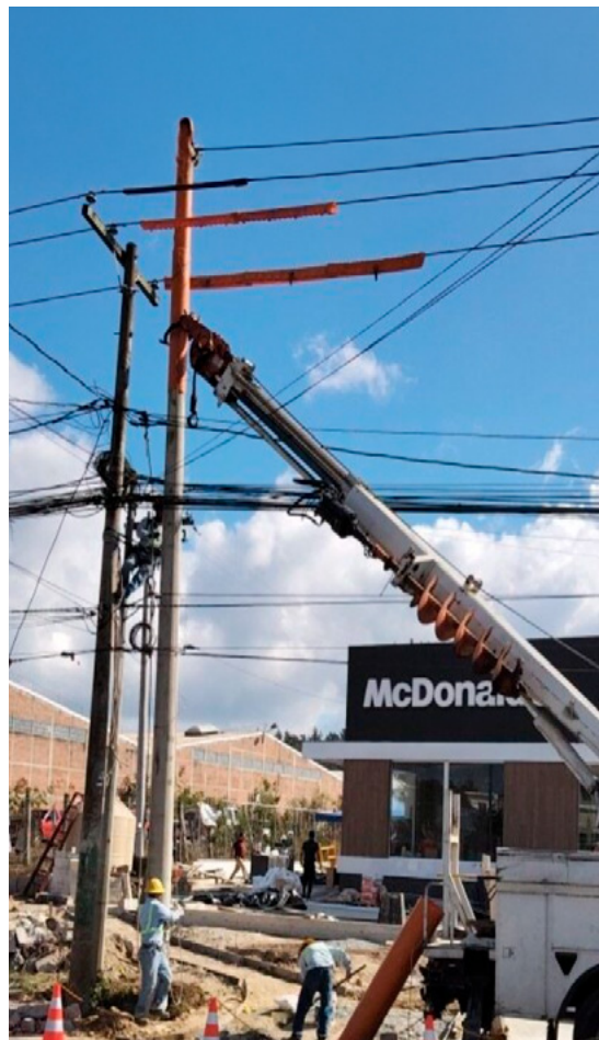
Construcción Media Tensión, interconexión McDonald's Amatitlán y San José Pinula.
